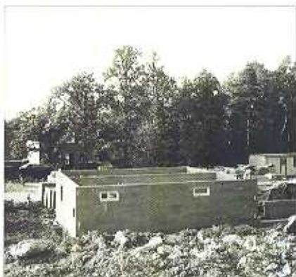
Första våningsplanet färdigt innan upplynad av jordmassor mot väggen
