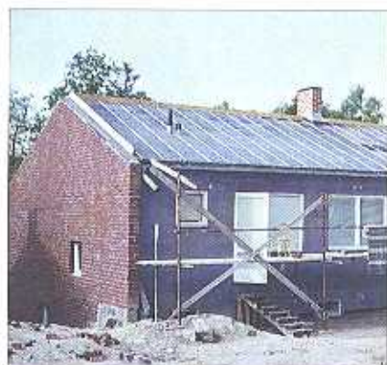
Tegelgåveln är färdig och merken är utflytt
