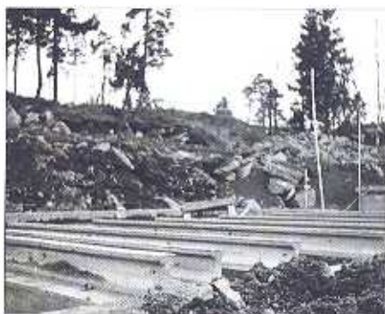
Betsgrundament till bottenväggar
